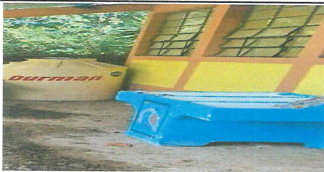
Foto 3: Instalacion denueva pila en proceso.
