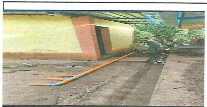
Foto 6: Tuberia de aguas pluviales en proceso
