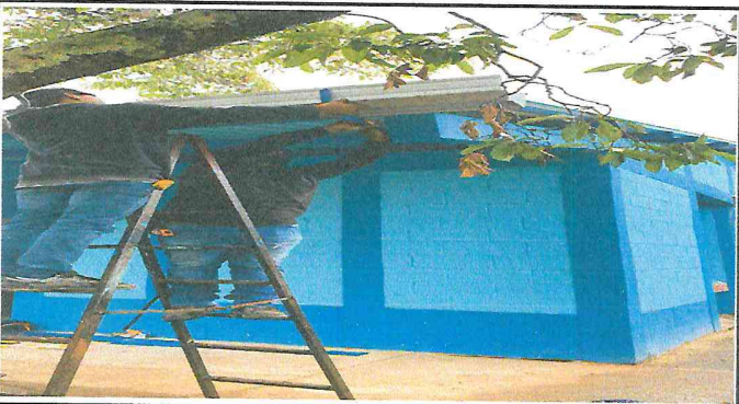
Foto 3: Colocacion de canales.
